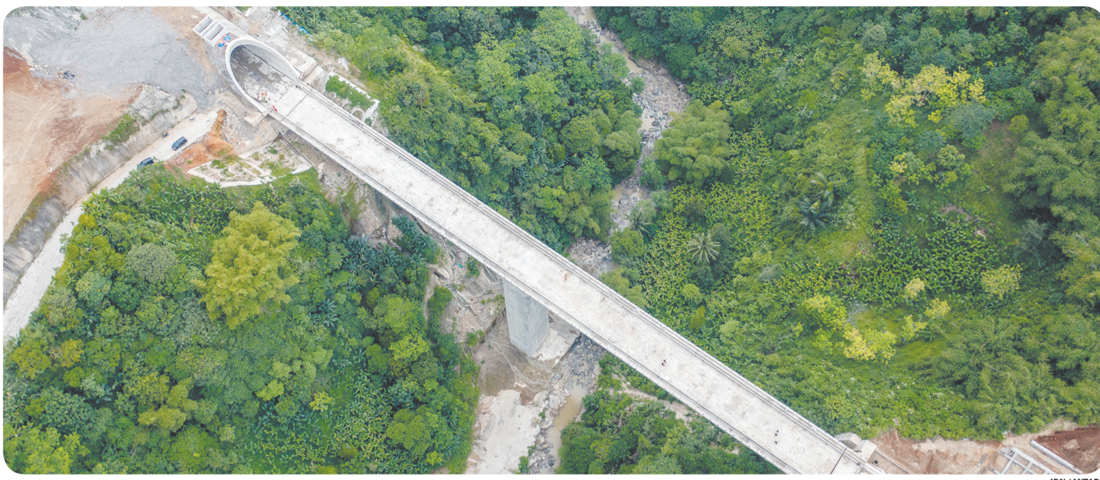
JEMBATAN DK88 KERETA CEPAT JAKARTA-BANDUNG
